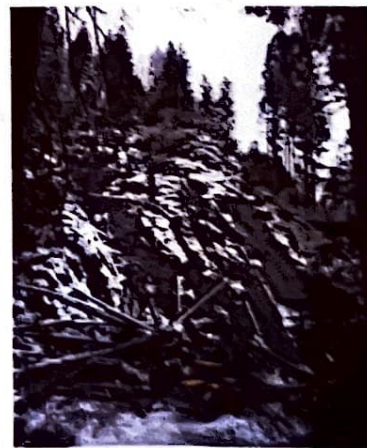
Der Hangrutsch in extremem Gelände am Sölkbach wurde von Andreas Leitgab unter schwierigen Bedingungen aufgearbeitet. Foto: Leitgab
